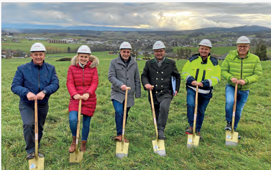
Spatenstich vlnr.: Christian Tidl (Geschäftsführer der WG), Kathrin Seyringer (GF-Stellvertreterin der WG), Bürgermeister Norbert Weber, Ziviltechniker Ernst Köttl, Franz Scheibl (Baugruppe Spindler), Dietmar Minniberger (flashnet) Foto: Wassergenossenschaft.
