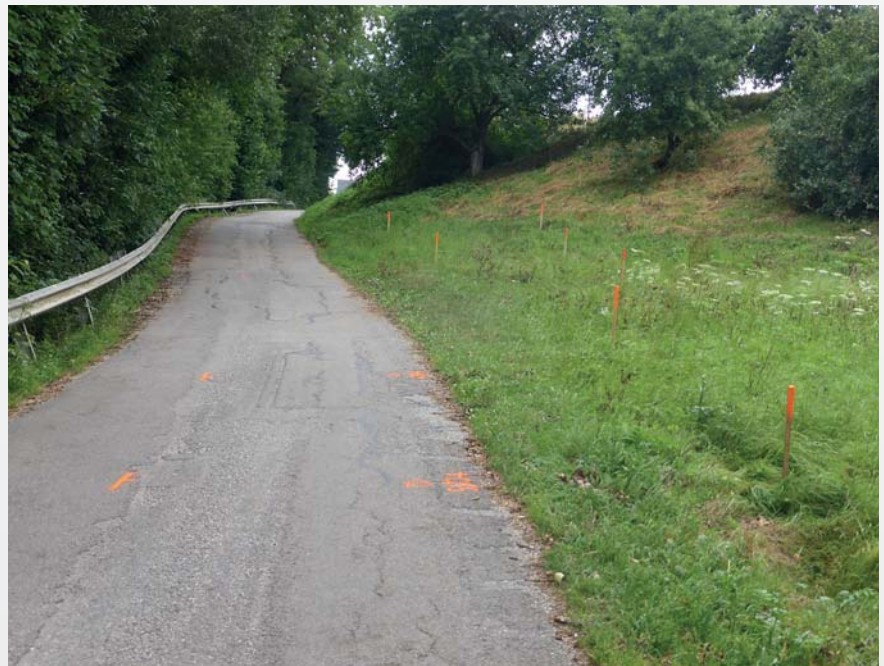
Im Bereich des Wurhügels wird die Zipfer Straße verlegt.
